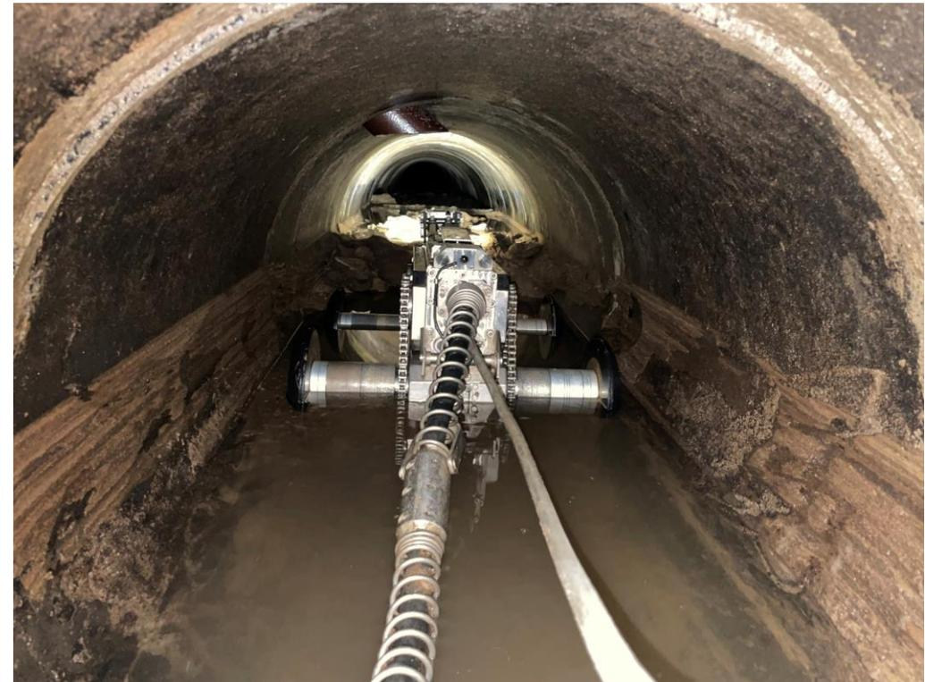
Entfernung von Inkrustationen, Kalk und anderen natürlichen Ablagerungen mit Wasserhöchstdruck
