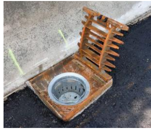
Punktentwässerung auf Fernstraßen mit Multitop-Aufsätzen
